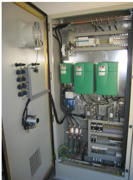
Obr. 7 Vlevo část armaturní komory, vpravo pohled do prvního pole skříňového rozvaděče na tři měniče frekvence
