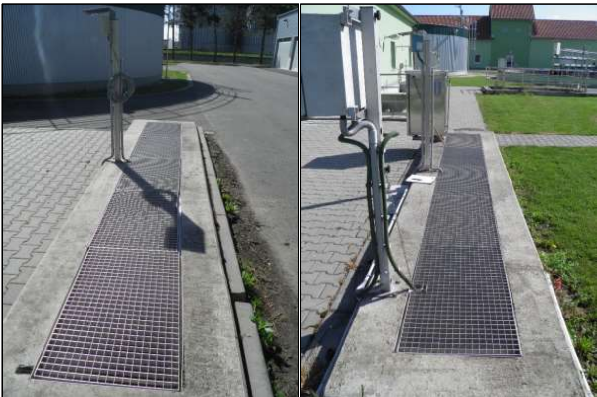
Obrázek 2 Šachtice s napevno instalovanými měřicími systémy průtoku ČOV Slavkov
