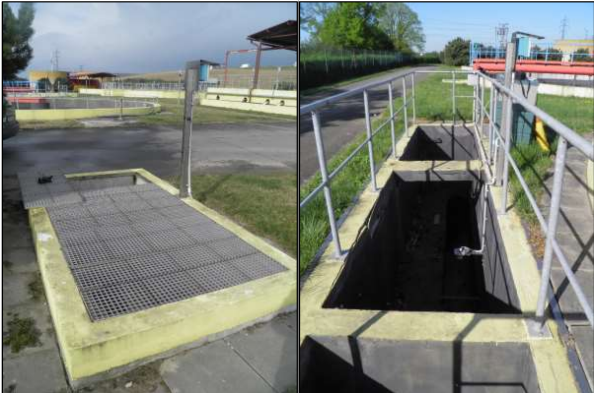
Obrázek 1 Šachtice s trvale instalovanými měřicími systémy průtoku ČOV Bučovice
