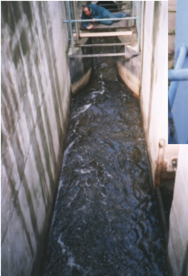
Posouzení přesnosti a funkční způsobilosti instalovaného žlabu a systému měření průtoku a proteklého množství na odtoku z čistírny odpadních vod
