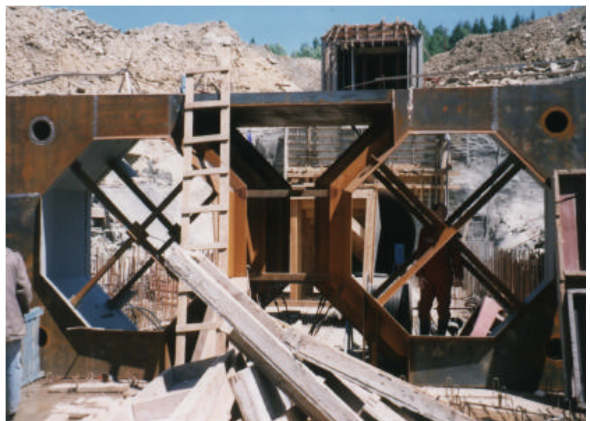
Obr. 6.9 Protiproudění pohled na usmernovace výtokových paprsků z rozstrikovacích uzáverů spodních výpustí VD Morávka (model a realizace na stavbě)
