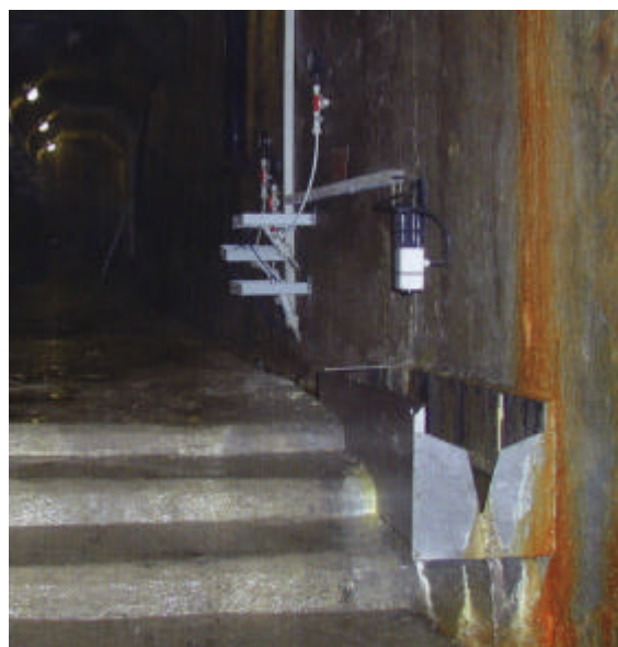
Obr. 10.4 Kalibrace vestavbové konstrukce s ostrohranným složeným prelivem na hydraulickém žlabu a jeho následné umístění ve štolě VD Morávka pro sledování průtoku prosáklé vody (součást monitorovacího systému TBD)
