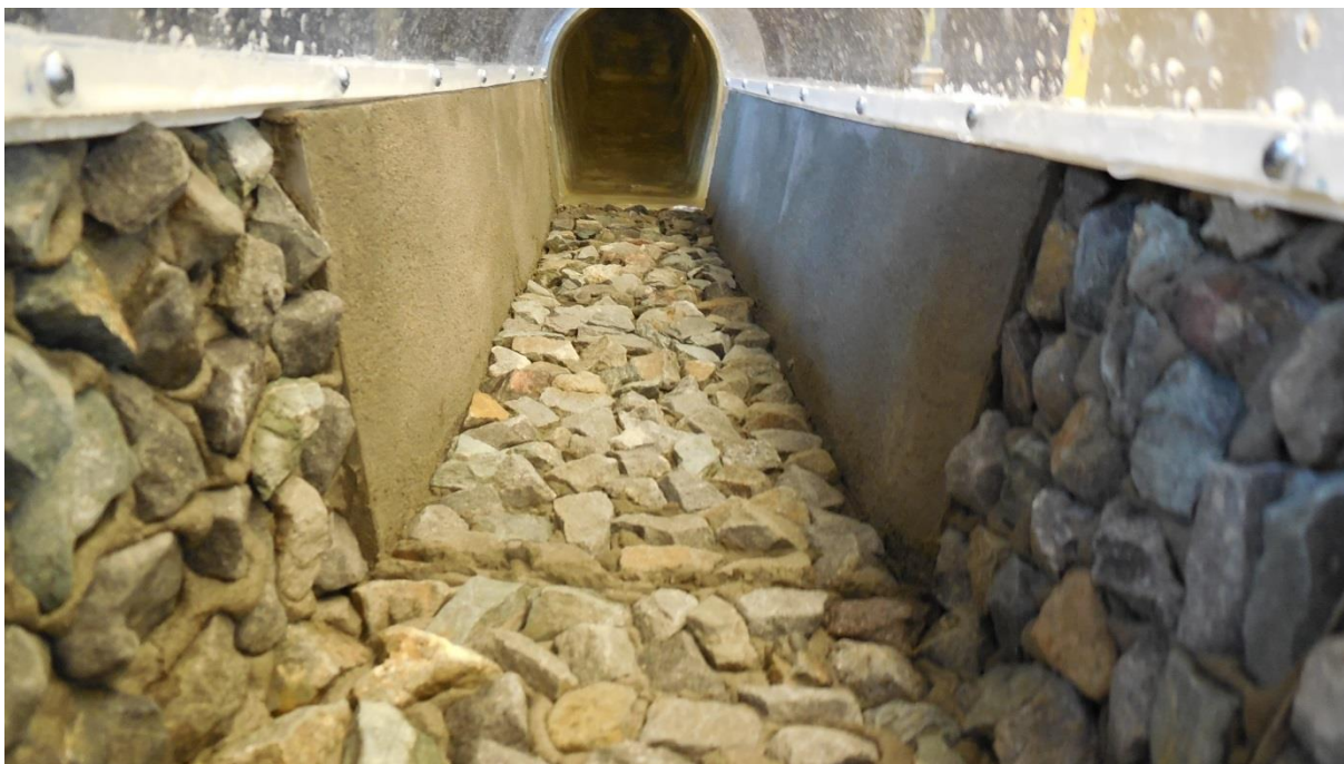
Štola šachtového přelivu
