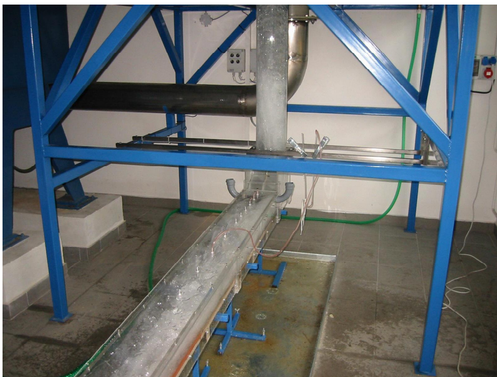
Foto 5. Zahlcení odpadní štolý v počátečním úseku, výstup pulzující hladiny a vodní tříště v prostoru šachty (současný stav, Q_{\text{skut}} = 115 \text{ m}^3 \cdot \text{s}^{-1} )
