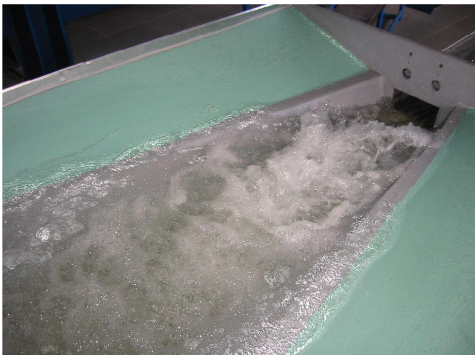
Foto 8. Pohled na výtök proudu z odpadňí štolý ( Q_{skut} = 94 \text{ m}^3 \cdot \text{s}^{-1} ), otvory nad výtökovým profilem představují vyústění spodňích výpustí DN 800
