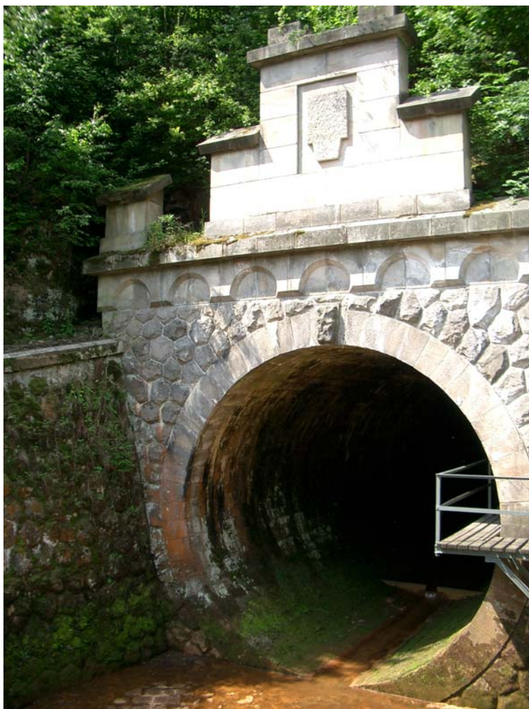
Vyústění pravé obtokové štoly
