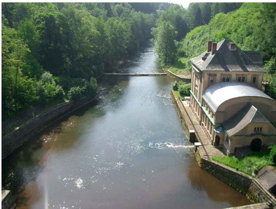
Budova průběžné vodní elektrárny na pravém břehu pod hrází
