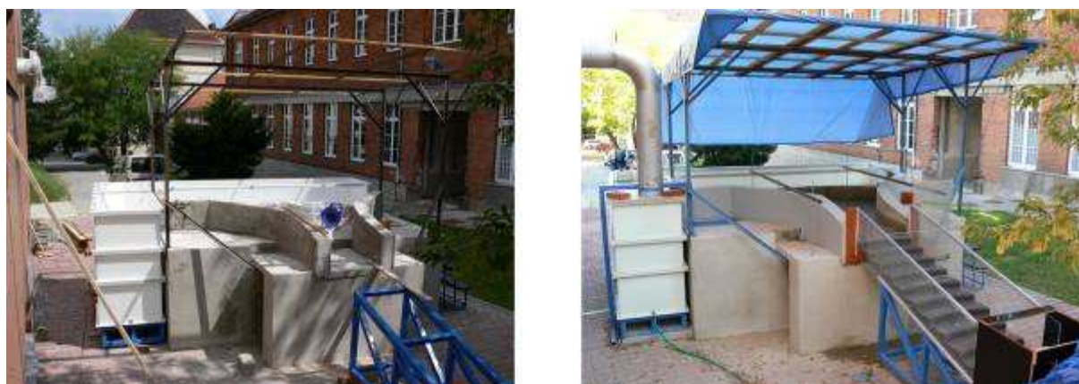
Obr. 7. Pohled na model bezpečnostního přelivu VD Bystřička v průběhu výstavby a po dokončení.
