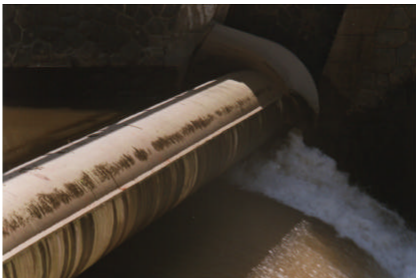
Obr. 6.34 Válec jednoho pole pohyblivého jezu Doksany, na povrch válce navarena „odtrhávací“ lišta, výtok je realizován pod zdviženou konstrukcí
