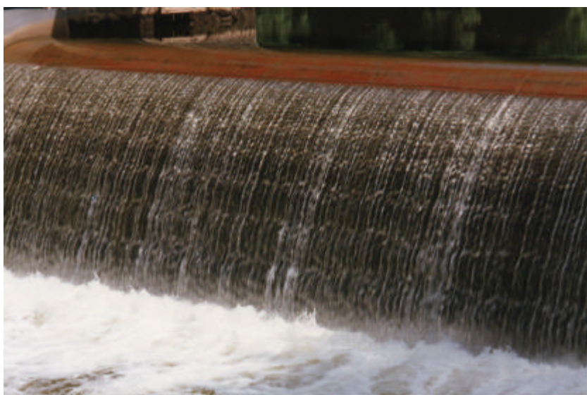
Obr. 6.35 Nestabilita válce a prepadajícího paprsku na jezu Doksany
