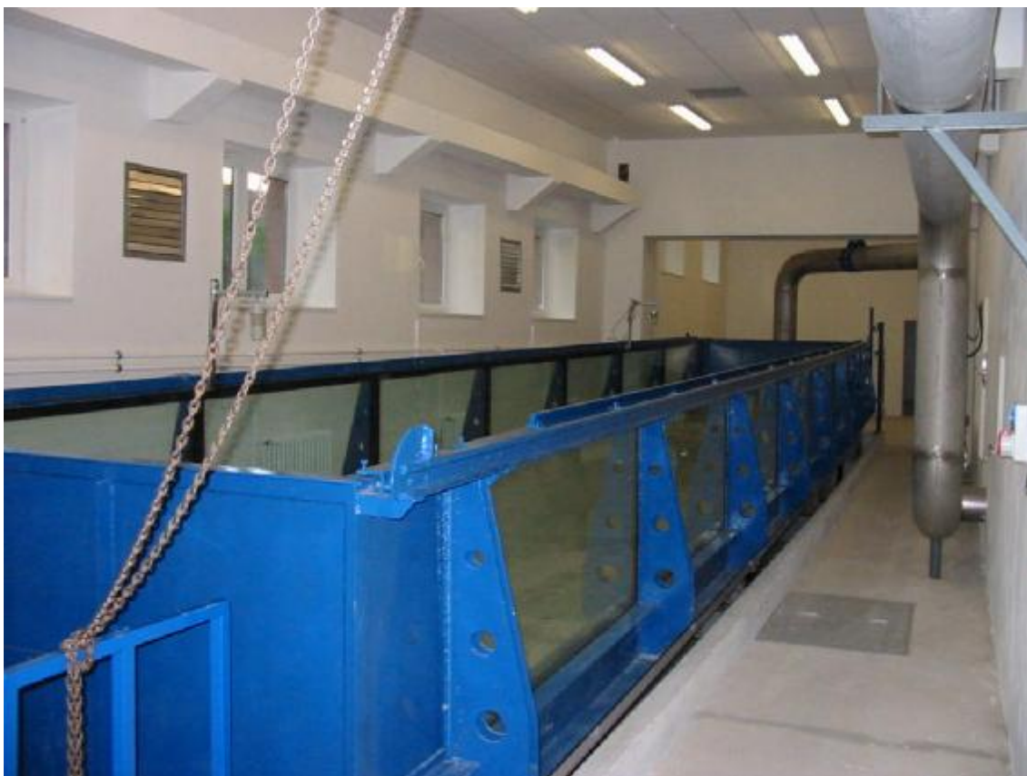
Obr 4. Pohled na žlab 240 - konečné řešení
