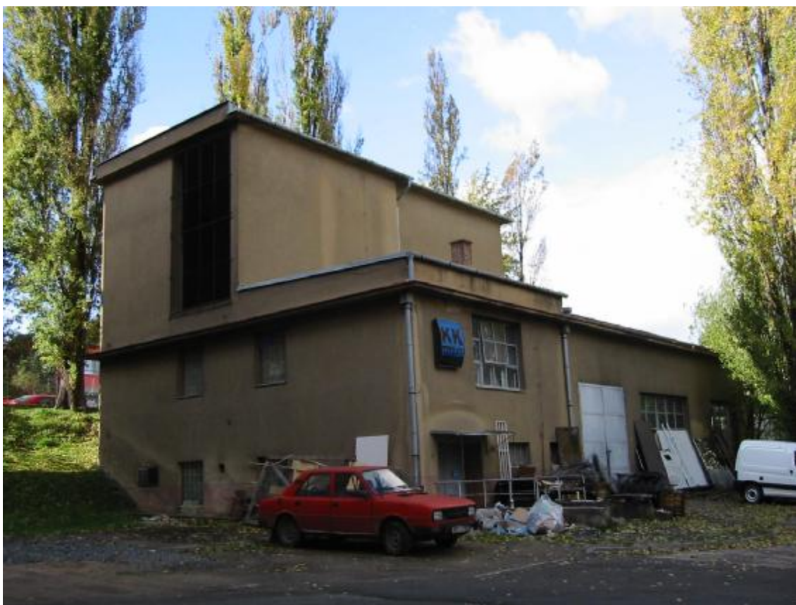
Obr 1. Pohled na budovu F před rekonstrukcí
