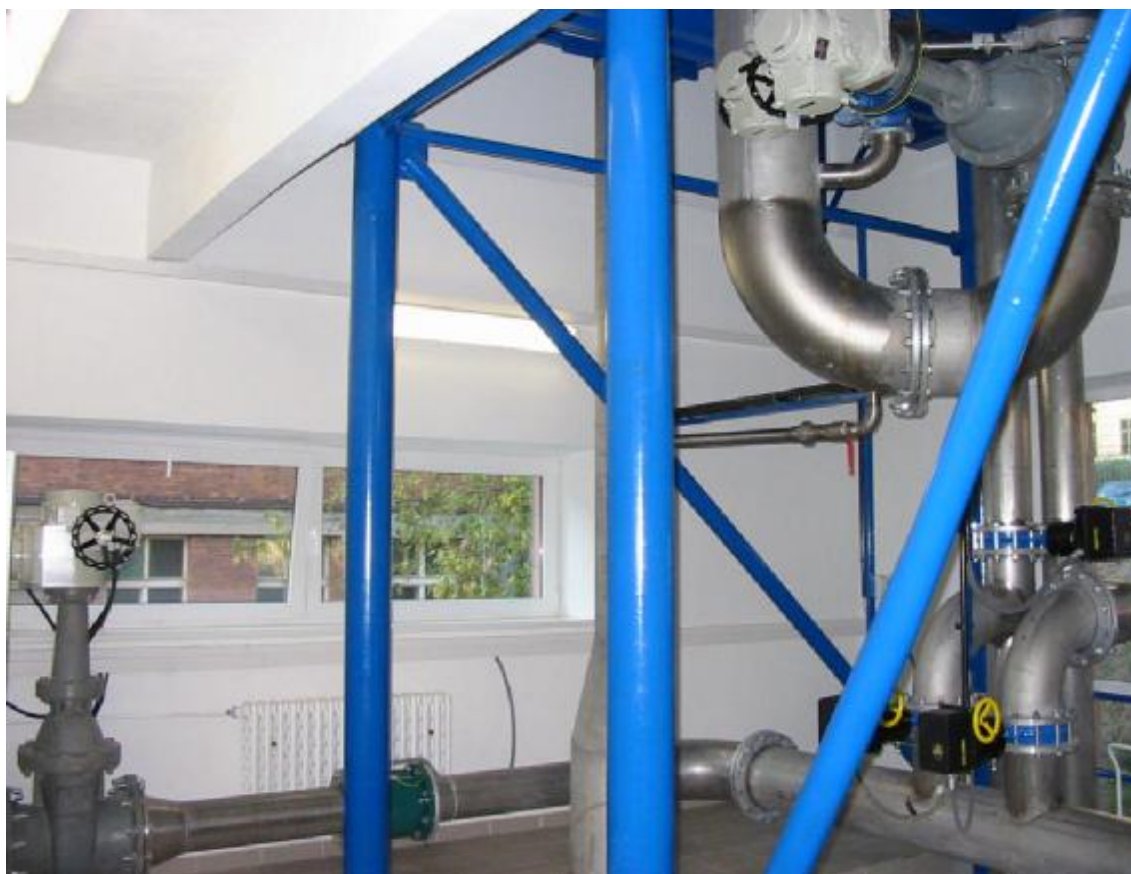
Obr 7. Pohled do armaturní komory, modře natřená nosná konstrukce horních nádrží
