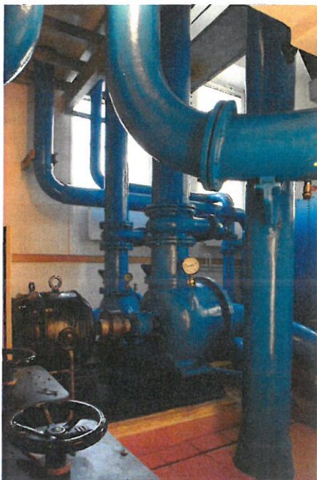
Obr. 1. Čerpací stanice s „turbopumpami“ krátce před její rekonstrukcí v roce 2008
