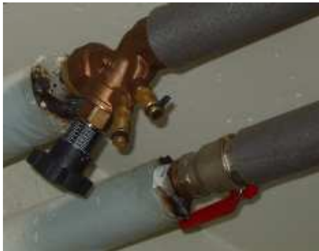
Seřizovací ventil na patě stoupačky
