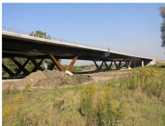
Obr. 2 Pohled na dokončený most
