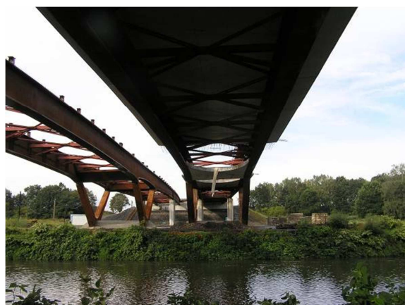
Obr. 1 Pohled na most během výstavby
