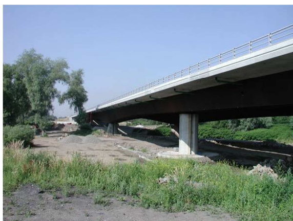
Obr. 1 Pohled na dokončený most
