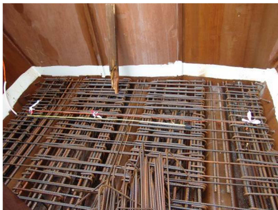
Obr. 4 Instalace čidel v dolní desce – čidla B6-B8
