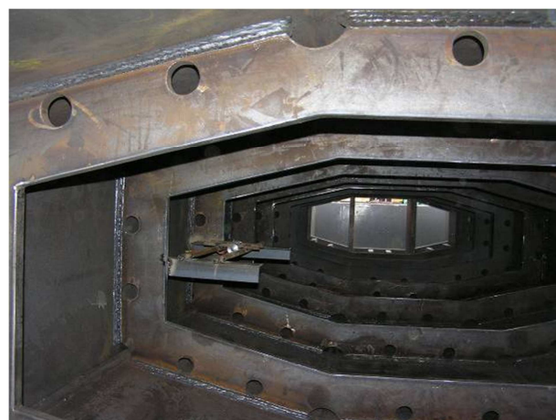
Obr. 11 Pohled na dutiny pylonu na instalované tenzometry
