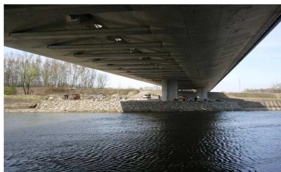
Obr. 3 Pohled na dokončený most od řeky
