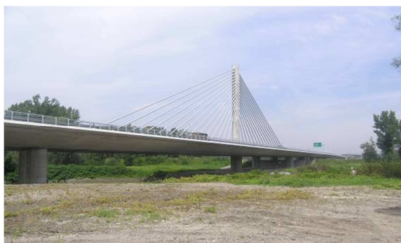
Obr. 2 Pohled na dokončený most
