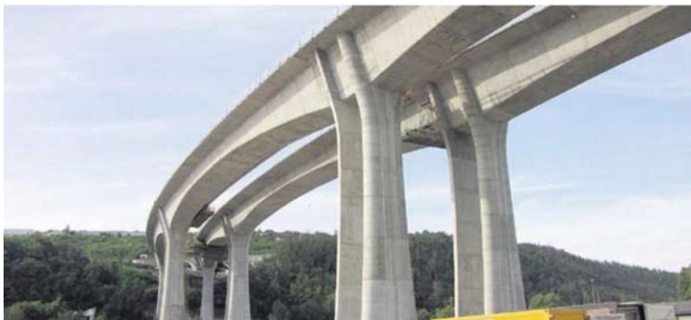
Obr.: 12 Dálniční most
