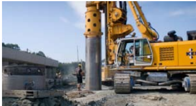
Obr.: 9 Vrtačka na piloty
