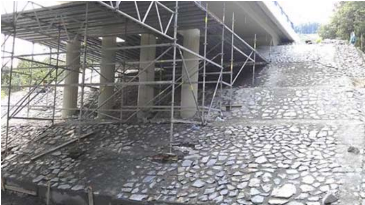
Obr.: 24 Dlažba pod mostem
