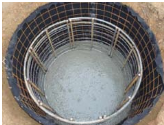
Obr.: 10 Zalitá pilota
