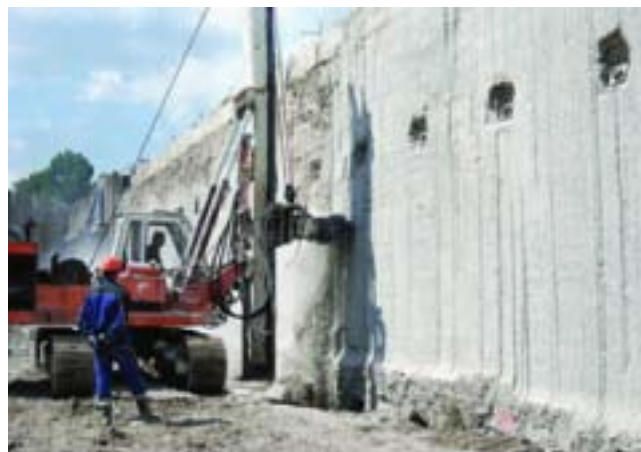
Obr.: 11 Podzemní stěna
