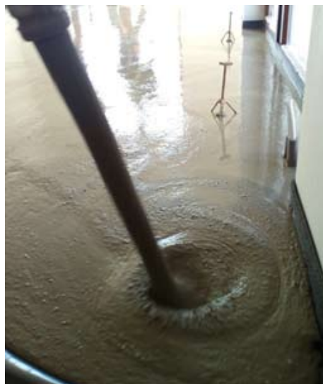
Obr.: 4 Ukládání ZAPA Slim
