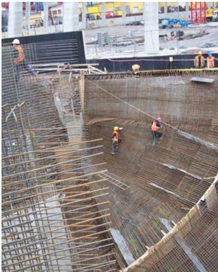
Obr.: 22 Bílá vana - silně vyztužená konstrukce
