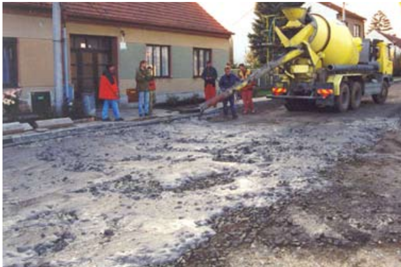
Obr.: 15 Rozprostírání ŠCM
