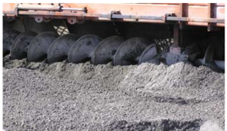
Obr.: 15 Ukládání KSC
