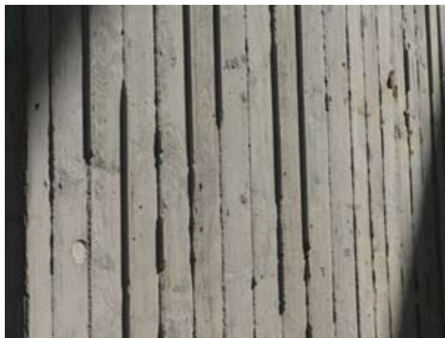
Obr.: 25 Stěna z SCC
