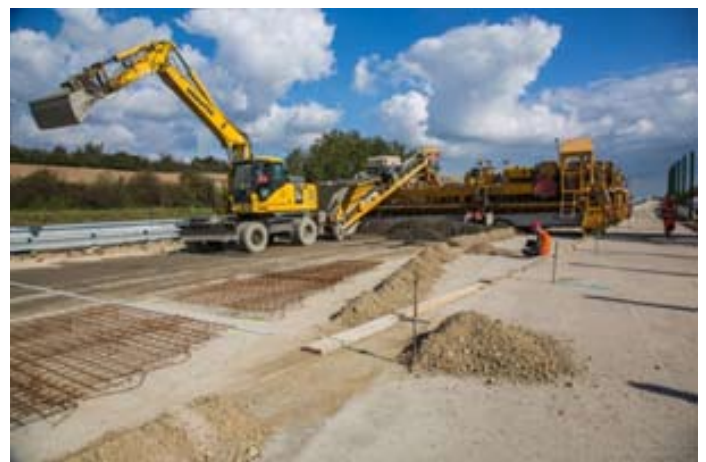
Obr.: 13 Pokládka dvouvrstvého CB I
