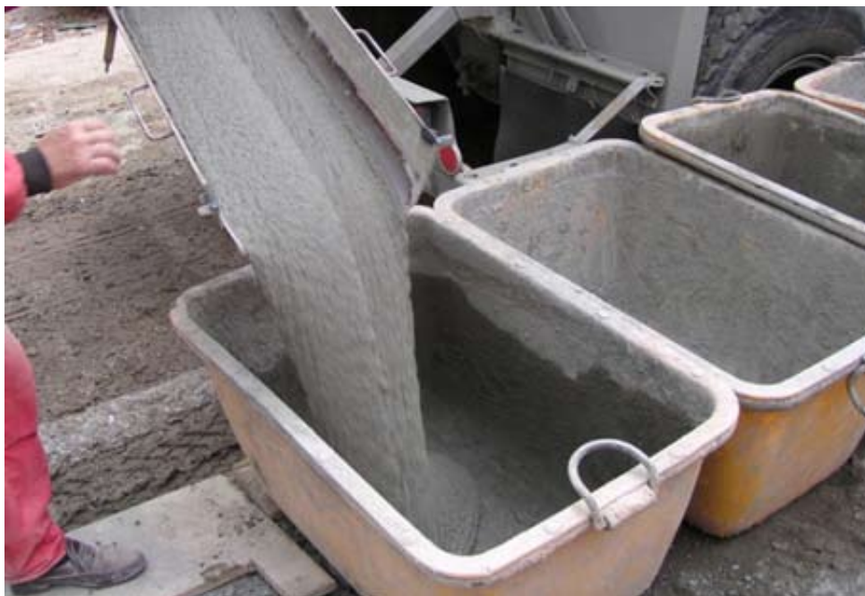
Obr.: 5 Doprava čerstvé malty na staveniště
