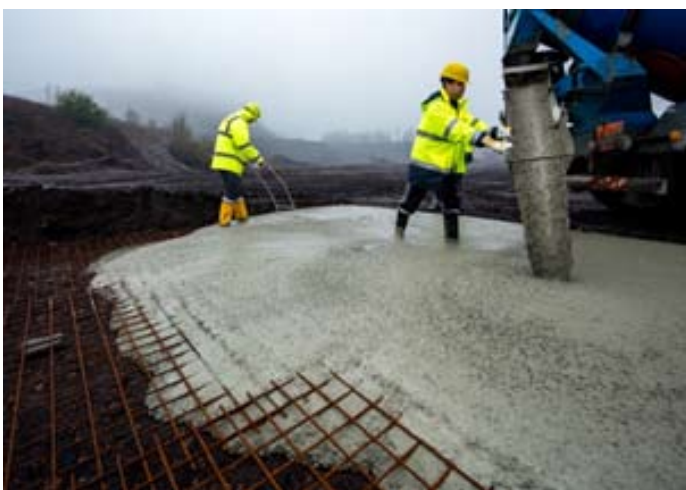
Obr.: 28 a Obr.: 29 Ukládání QCC
