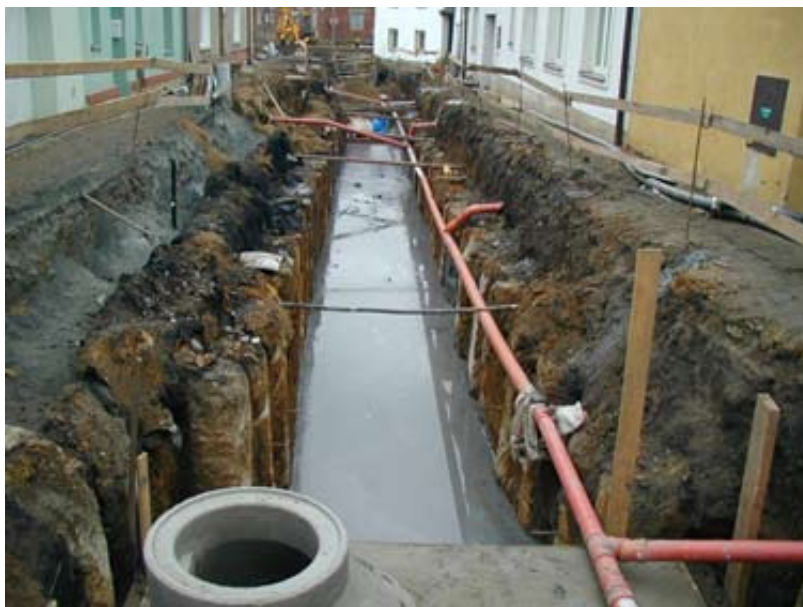
Obr.: 22 Potrubí zalité CPS
