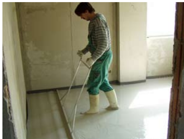
Obr. 2: Hutnění a srovnávání vrstvy ANHYSCREEDu
