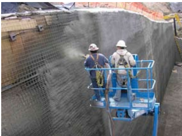
Obr.: 7 Torketování stěny
