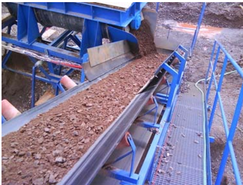
Obr.: 17 Stabilní míchací centrum na MZK
