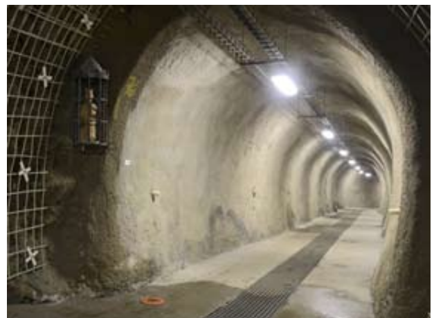
Obr.: 8 Stříkaná šachta
