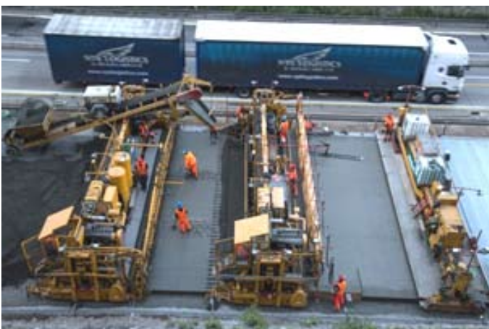
Obr.: 13 Pokládka dvouvrstvého CB I
