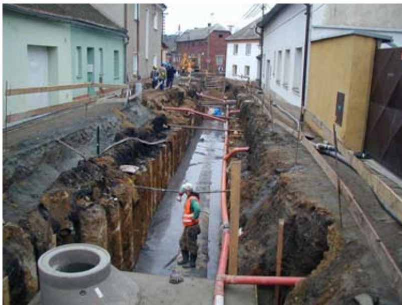
Obr.: 21 Potrubí zalité CPS
