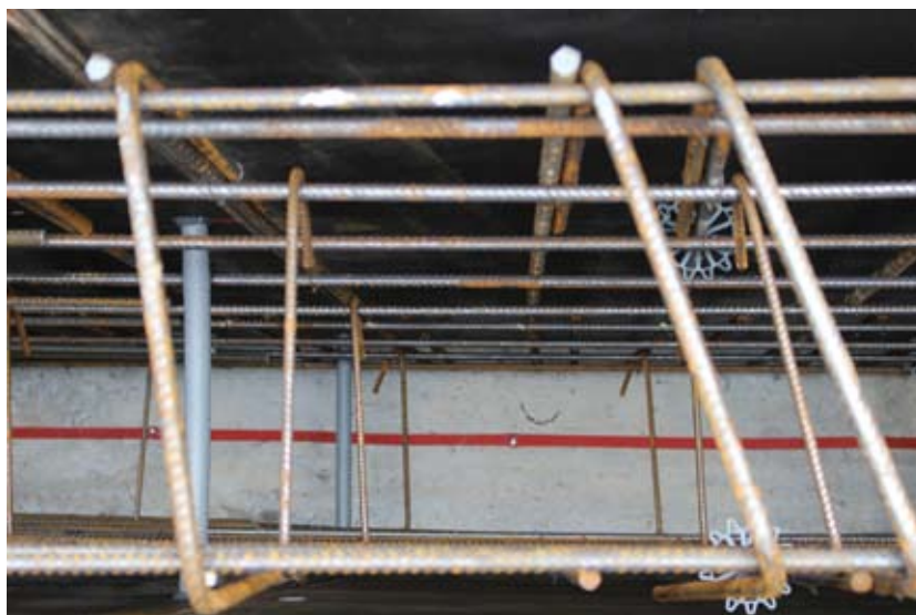
Obr.: 23 Těsnění pracovních spár
