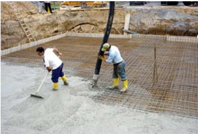
Obr.: 23 Ukládání SCC
