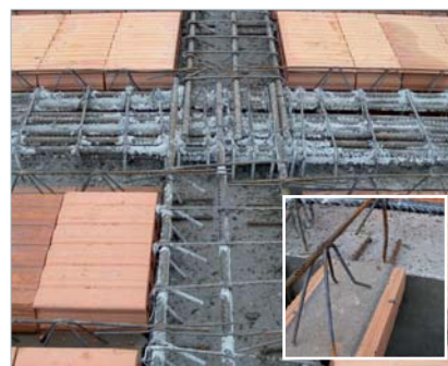
uložení trámečků do železobetonového průvlaku
