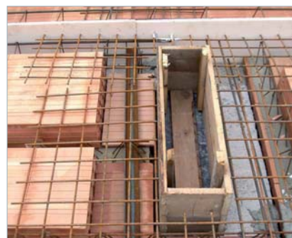
výměna u prostupu stropem pomocí vloženého úhelníku 75/50/6
