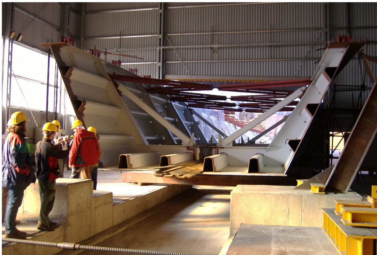
Obr. 10 Komorový nosník před vysunutím z provizorní haly
