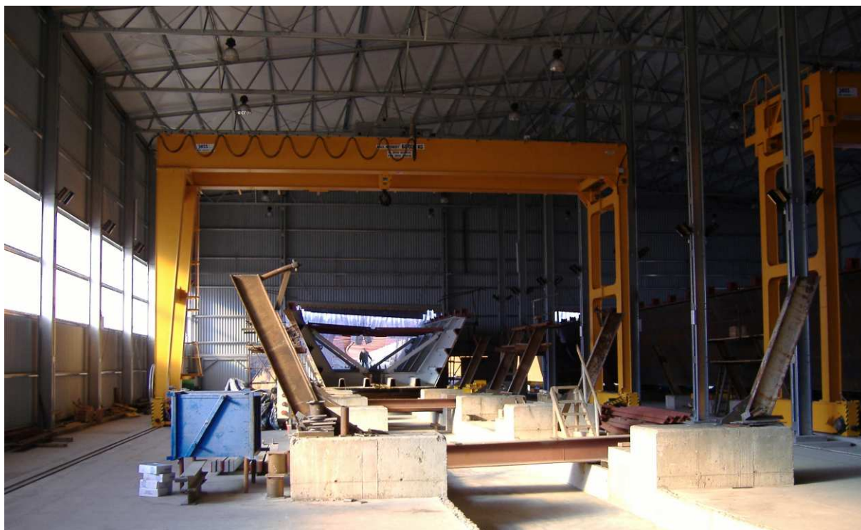
Obr. 9 Komerový nosník byl svařován v provizorní hale a z ní postupně vysouván
