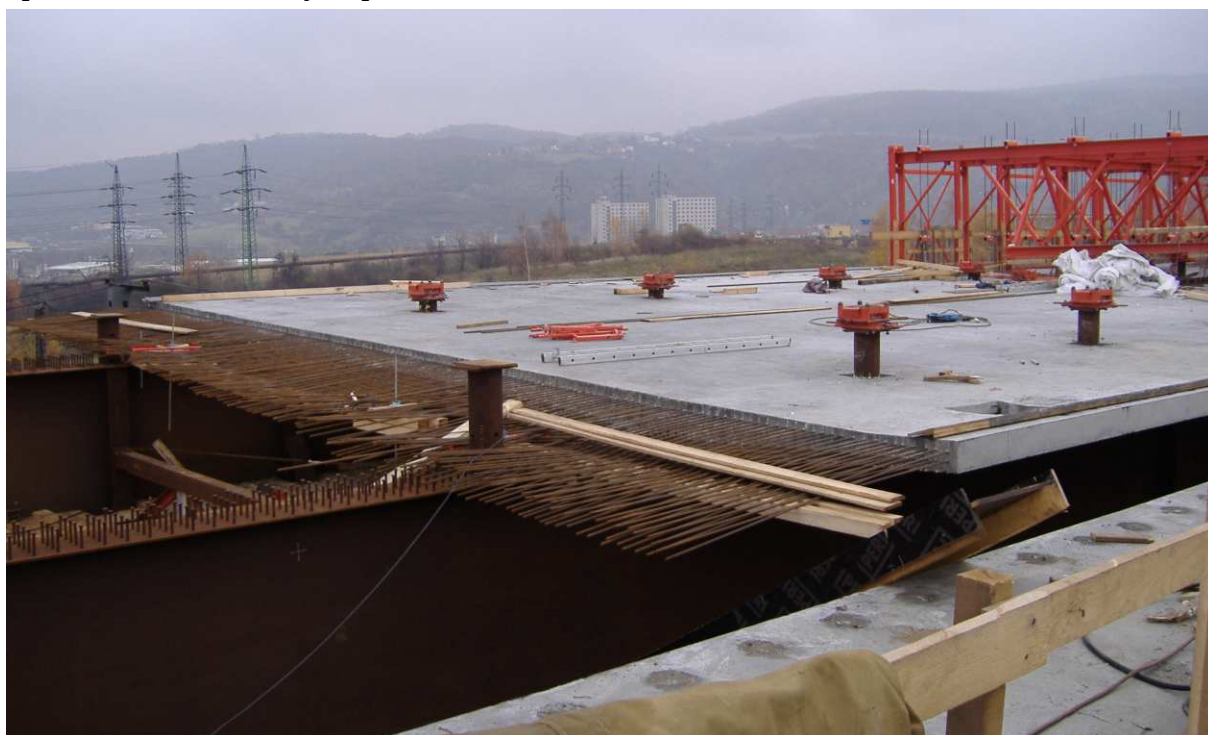
Obr. 7 Stavba komorového spřaženého mostu na dálnici D8 Praha - Ústí n.L. - státní hranice ČR/SRN
