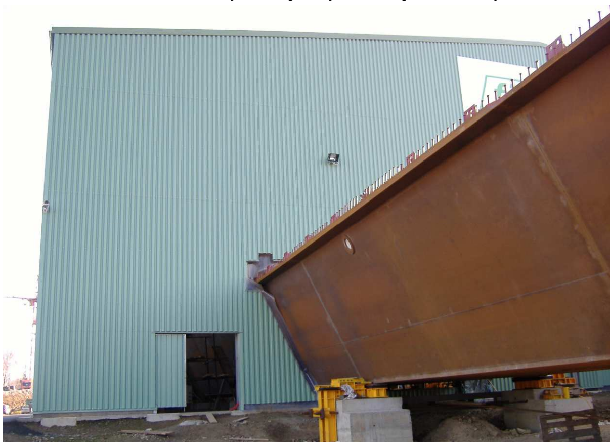
Obr. 11 Komorový nosník byl svařován v provizorní hale a z ní postupně vysouván
