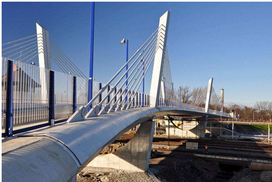
Obr. 12 Silniční most v Bohumíně – celkový vzhled [www.firesta.cz]
