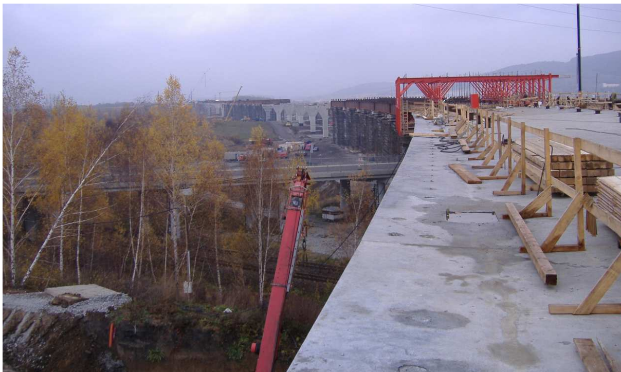
Obr. 8 Stavba komorového spřaženého mostu na dálnici D8 Praha - Ústí n.L.
