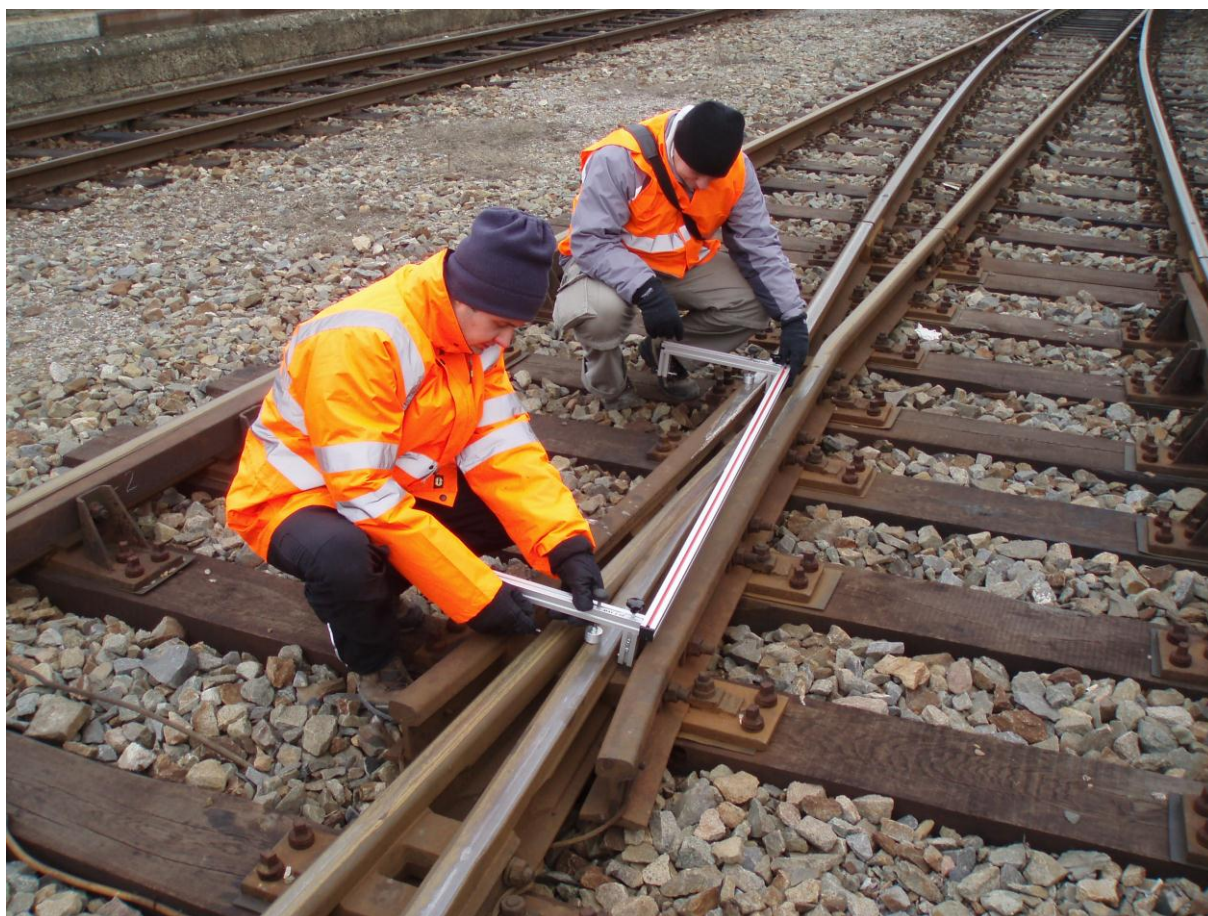
Obrázek 1 - Sestavování prostorové šablony PŠR-1 na srdcovce výhybky. K dokončení montáže chybí ještě připojit pomocný rám.
