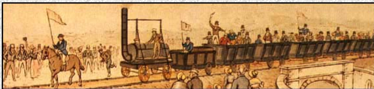
Obr. První veřejná jízda Locomotion
