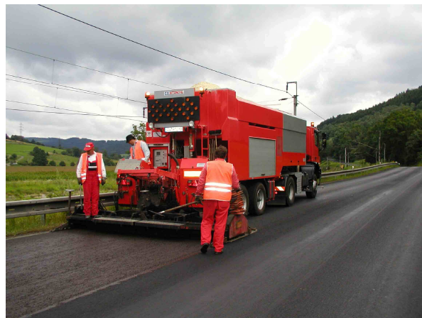
Obr. 2 Příklady údržby míst pro zvýšení protismykových vlastností (vlevo Rocbinda a vpravo mikrokoberec)
