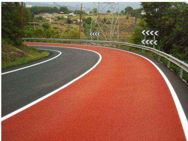
Obr. 2 Příklady údržby míst pro zvýšení protismykových vlastností (vlevo Rocbinda a vpravo mikrokoberec)
