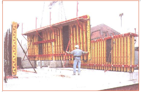
Bednění betonových a železobetonových konstrukcí
