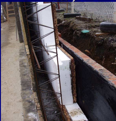
Provedení izolační přizdívky u podsklepené budovy
