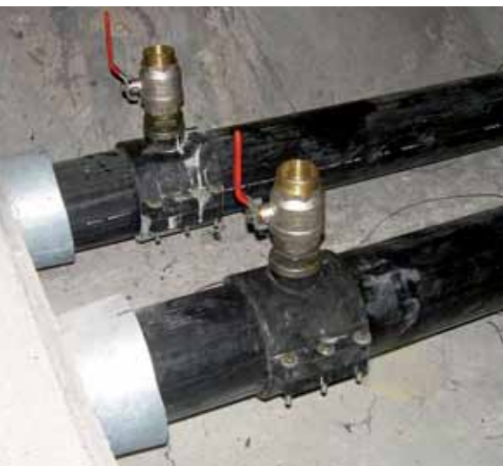
Injektážní vstupy na HDPE trubkách
