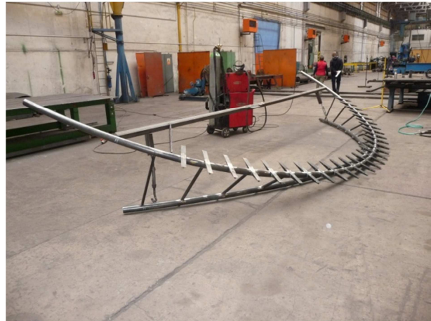
Obrázek 10 – Ocelová konstrukce po svaření
