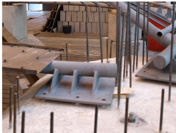
Obrázek 12 – Detail koncového příčniku
