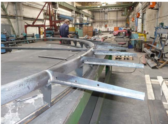
obr. 13 Svařování ocelové konstrukce
