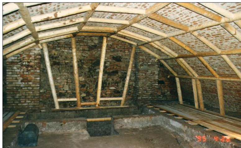
Obr. 56 Provizorní podskružení dřevěnými profily (cihelná klenba hrobky v kostele sv. Josefa v Brně)
