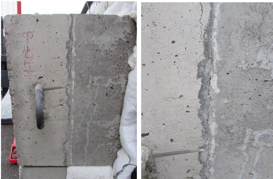
Obr. 33 Trhlina na rozmezí vrstev betonů po požární zkoušce
