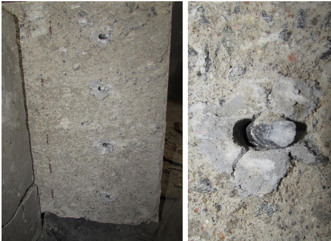
Obr. 21 Deformace betonářské výztuže po dosažení maximální únosnosti sprážení – bloky 2. etapy
