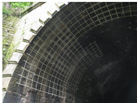
Obr. 53 Příložné sítě ze sklolaminátových pásků (Bohuslavický tunel)
