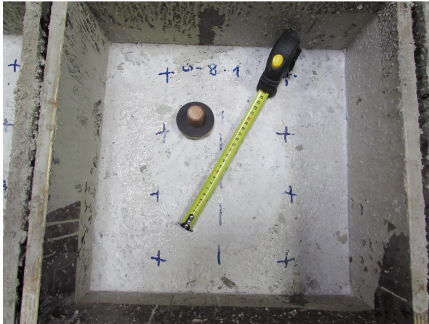
Obr. 13 Použití odměrné metody na 1. vrstvě betonu před navrtáním spřahovacích trnů
