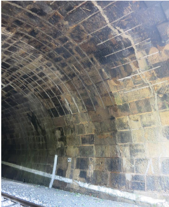
Obr. 50 Výztuž HELIFIX vlepovaná do drážek (podélná a příčná v klenbě tunelu Velký Prštický)
