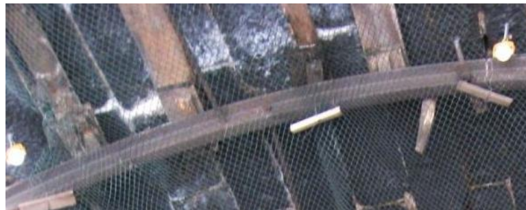
Obr. 55 Skružené válcované profily I – detail vyklínování dřevěnými klíny (Bohuslavický tunel)
