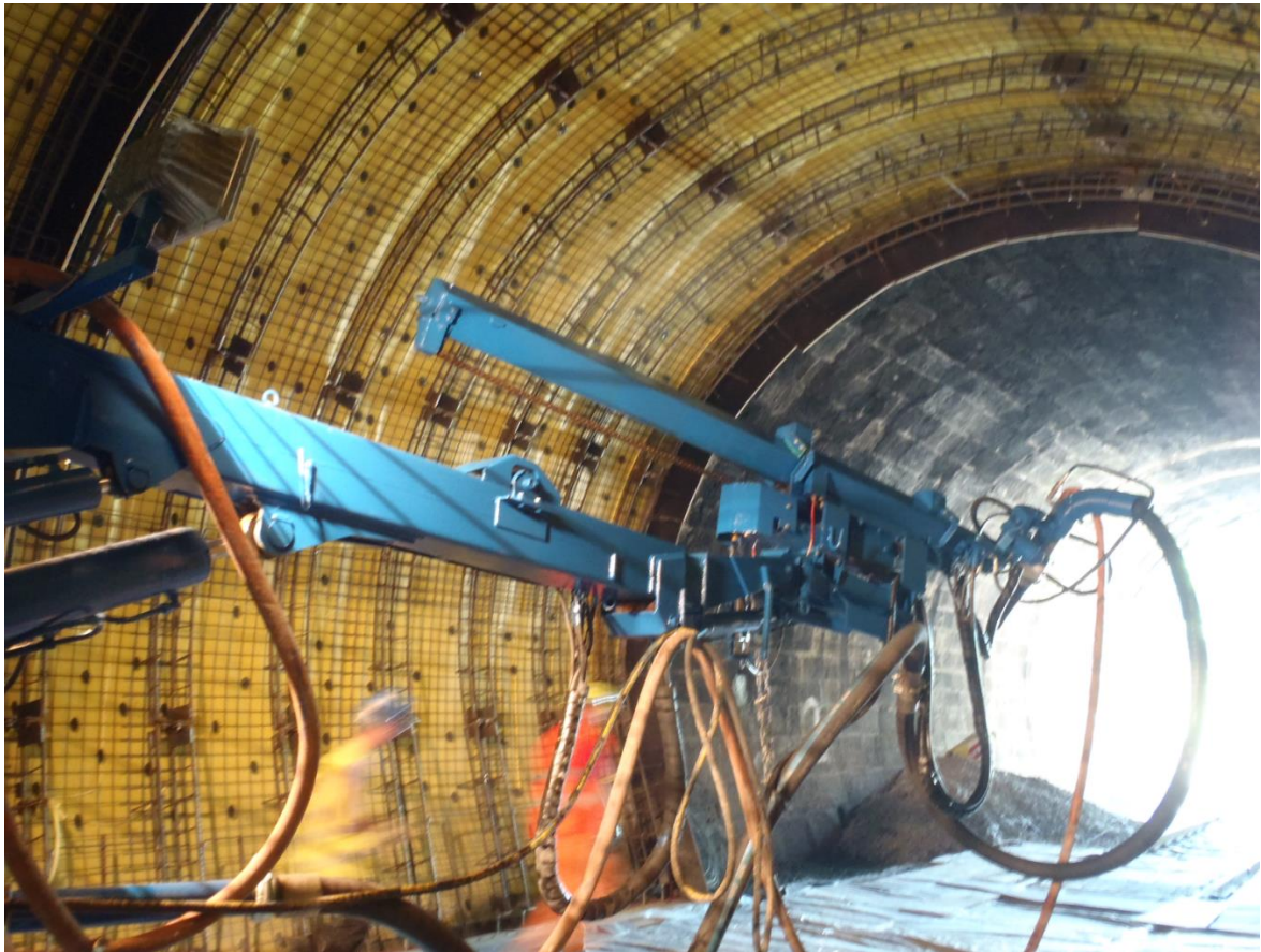
Obr. 49 Vybetonování nového ostění ze stříkaného betonu uvnitř starého (tunel Velký Prštický)
