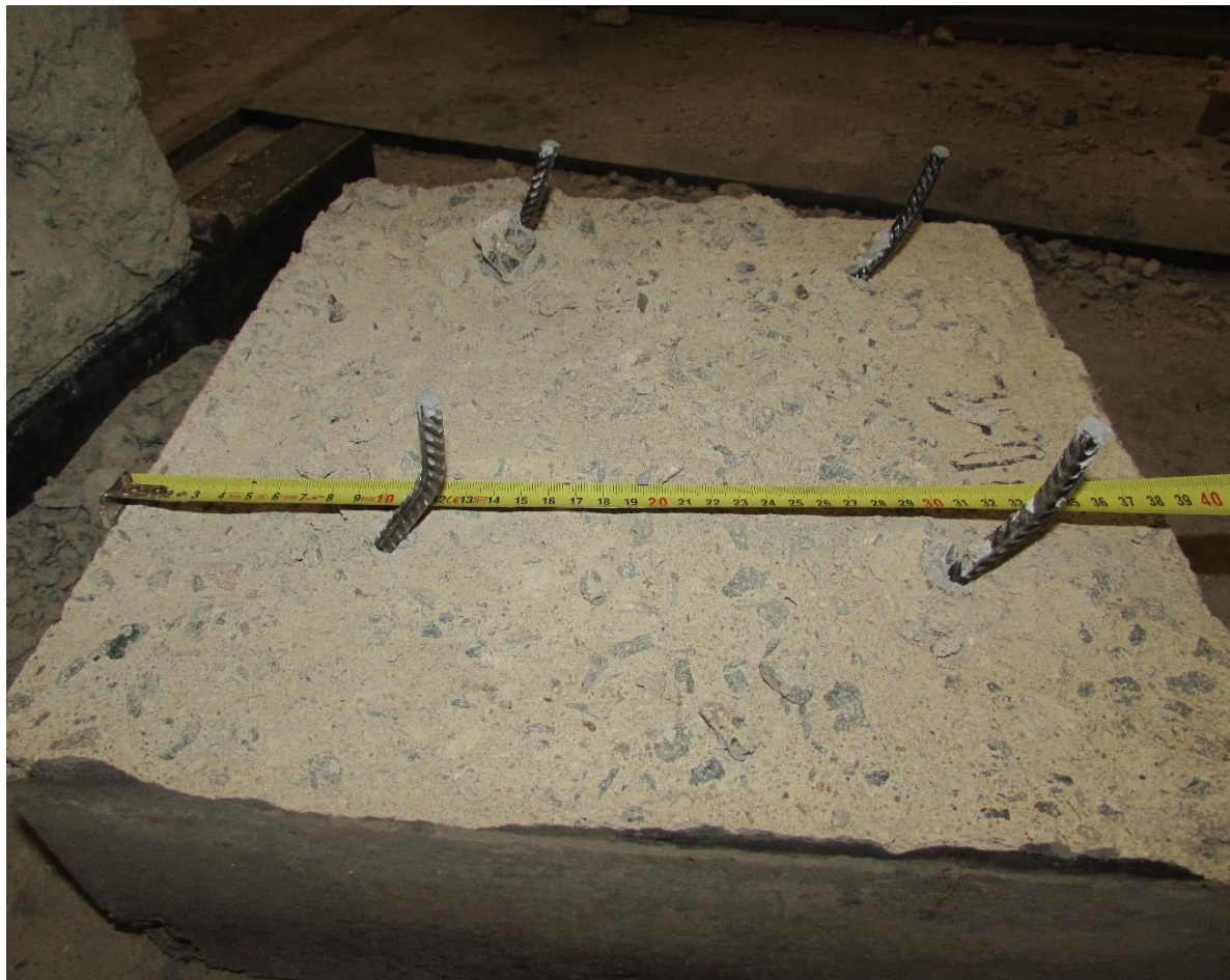
Obr. 36 Porušení bloku 3. etapy vytržením výztuže z „původní“ vrstvy betonu včetně části této betonové vrstvy
