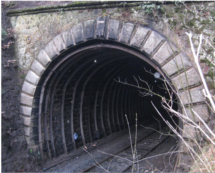
Obr. 54 Skružené válcované profily I (Bohuslavický tunel)
